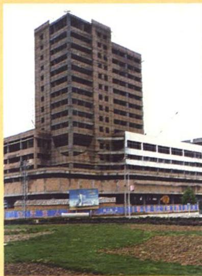
◀ 正在施工中的市土地局综合办公大楼——宝地大厦。
