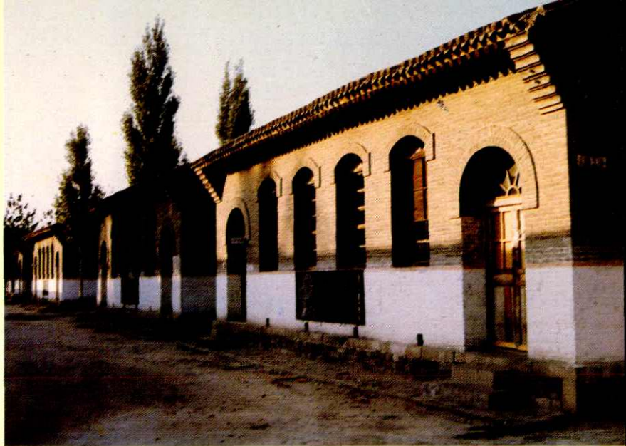
范亭中学旧址一角
