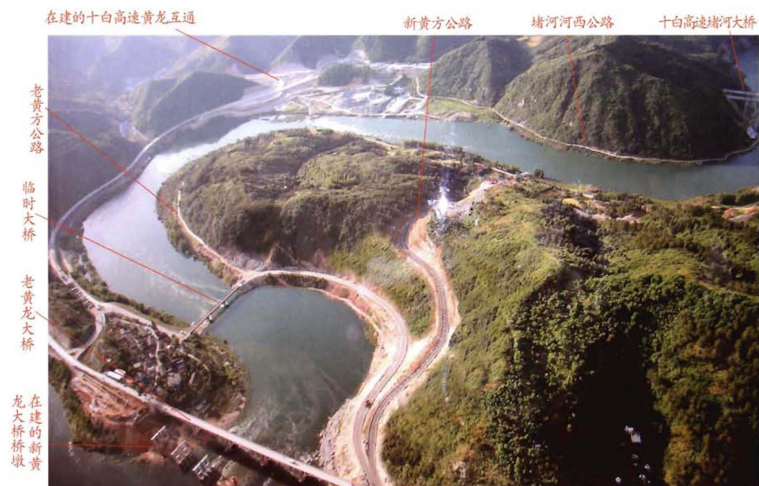
堵河龟山附近建设场景(2012年6月 摄)
