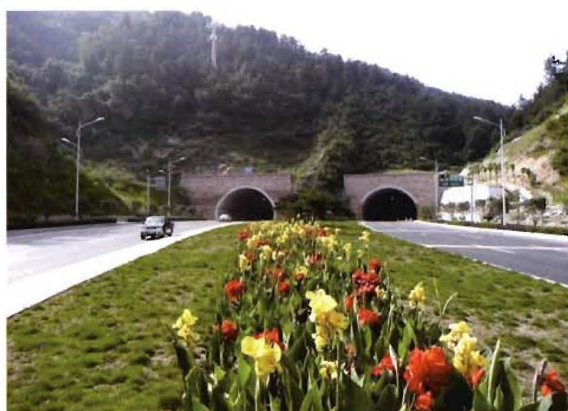
郧十一级路龙潭湾隧道(2013年7月 摄)
