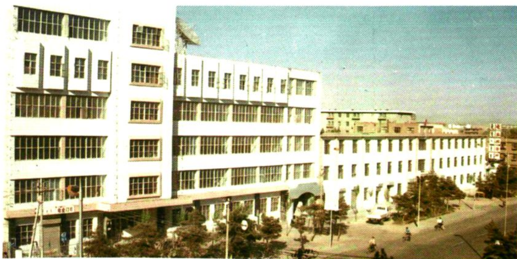
调试所、教育培训中心办公楼
