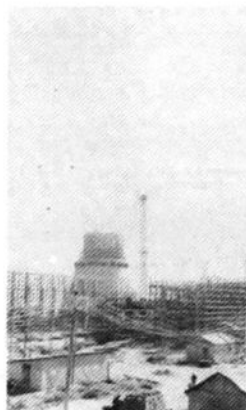
二电厂主厂房施工
