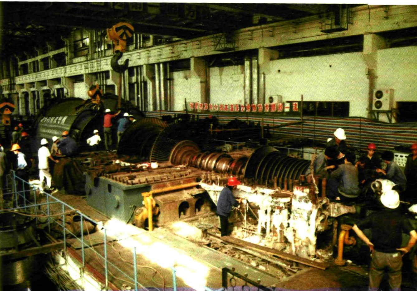
一电厂检修汽轮机
