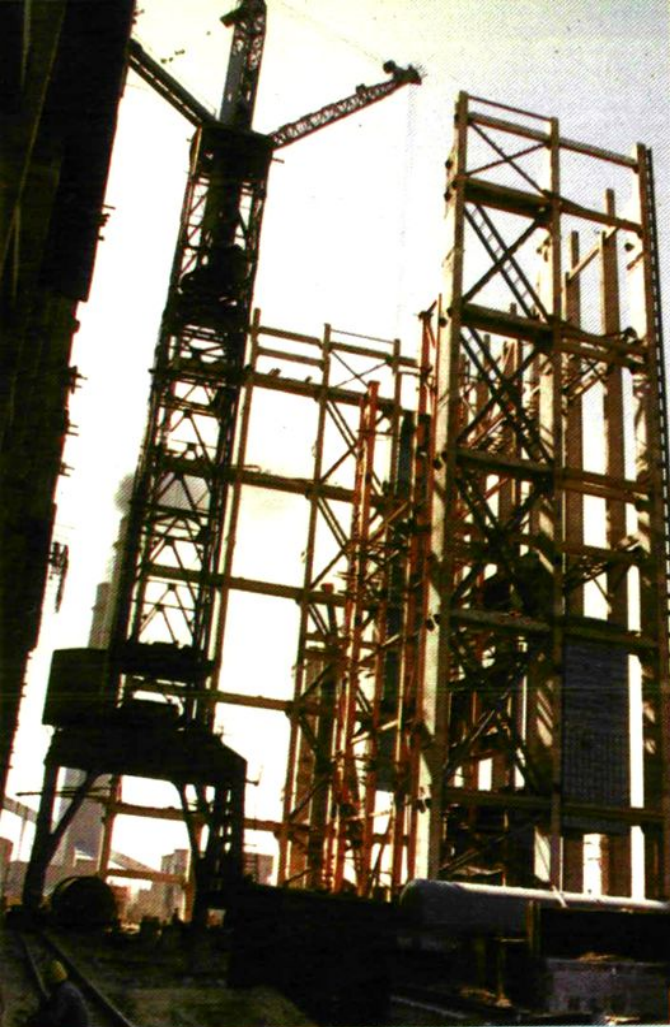
电建一公司进行设备吊装
