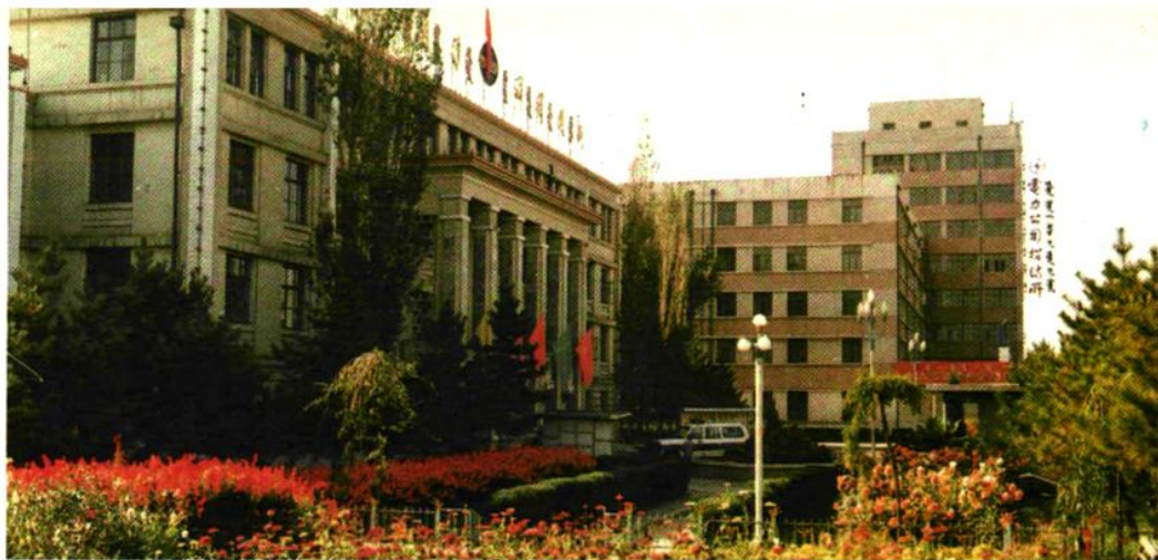
电建一公司办公楼
