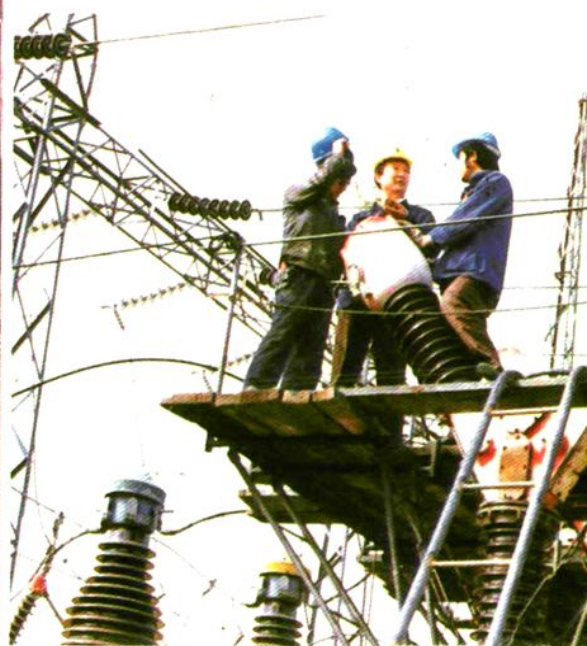
主变开关检修
