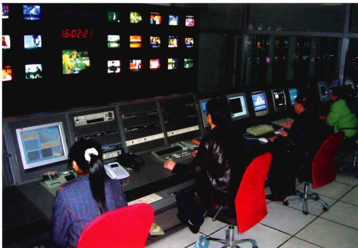
2002 年竣工投入使用的华蓥市广播电视播控中心
