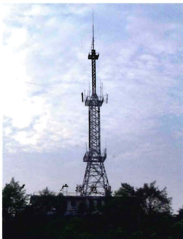
1987 年建成投入使用的华蓥市广播电视发射铁塔
