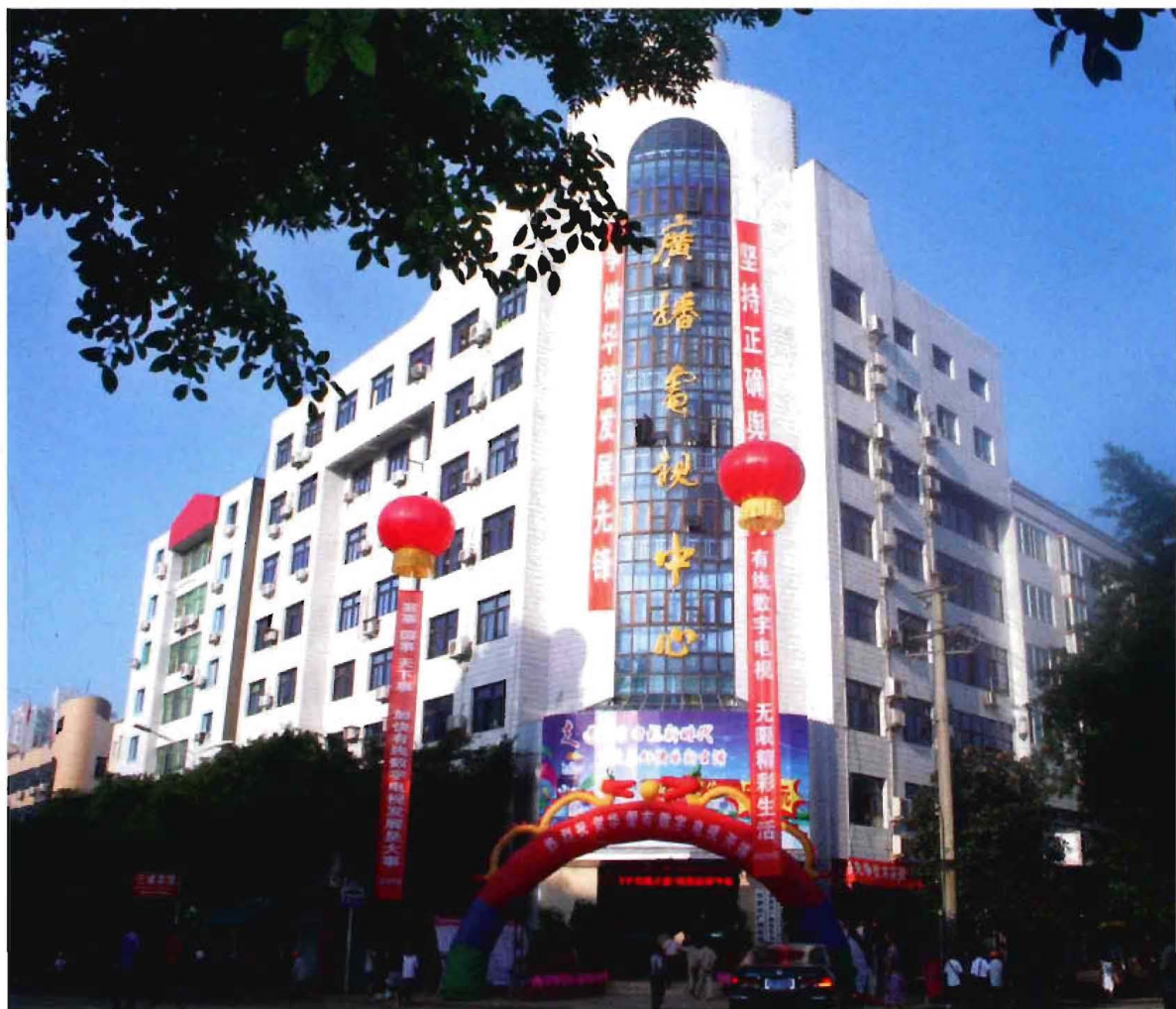
1996年10月竣工投入使用、建筑面积达5173.67m 2 的华蓥市广播电视中心大楼
