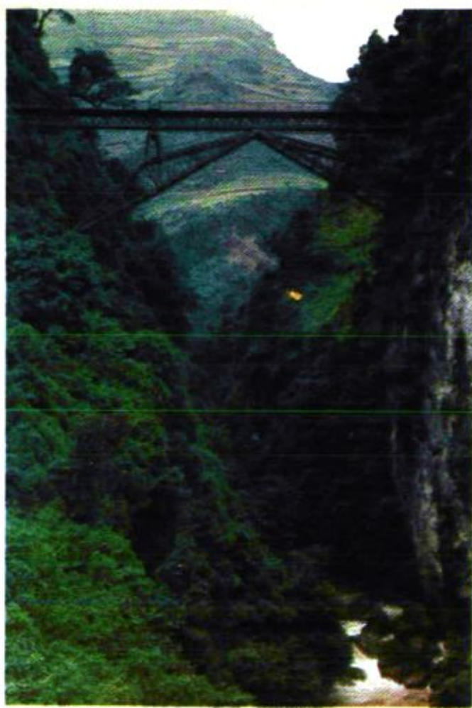
滇越铁路人字桥
