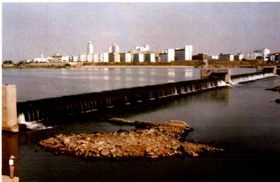
金华市市区河盘桥水利枢纽工程—橡皮坝
