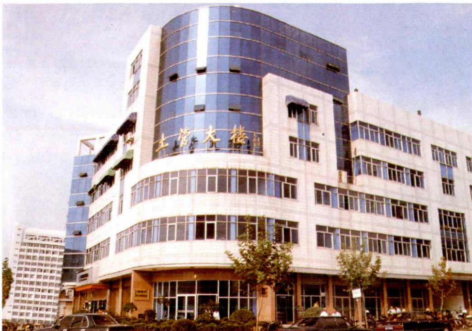
金华市国土管理规划局办公大楼
