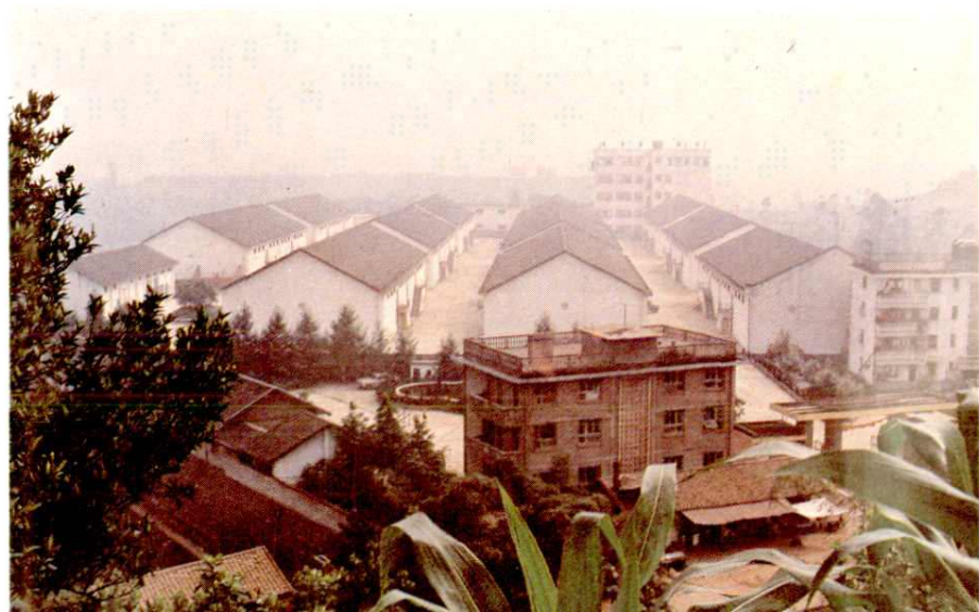
◀ 富顺县两路口仓库
