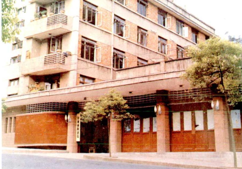
► 自贡市粮食局办公大楼
