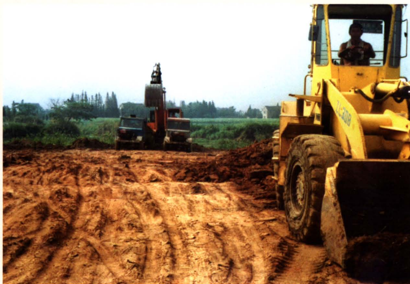
土地整理施工现场之一
