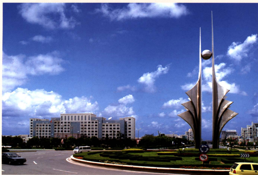
嘉善县人民政府 办公大楼及城雕“水 乡明珠”
