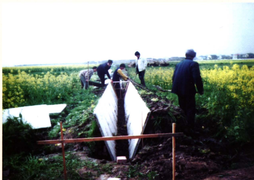
土地整理施工现场之二
