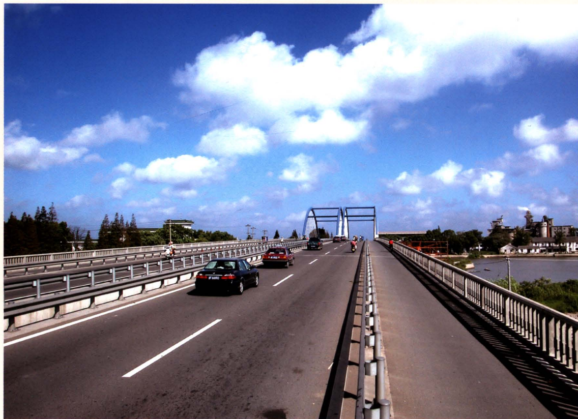
平黎一级公路嘉善段（善江公路）
