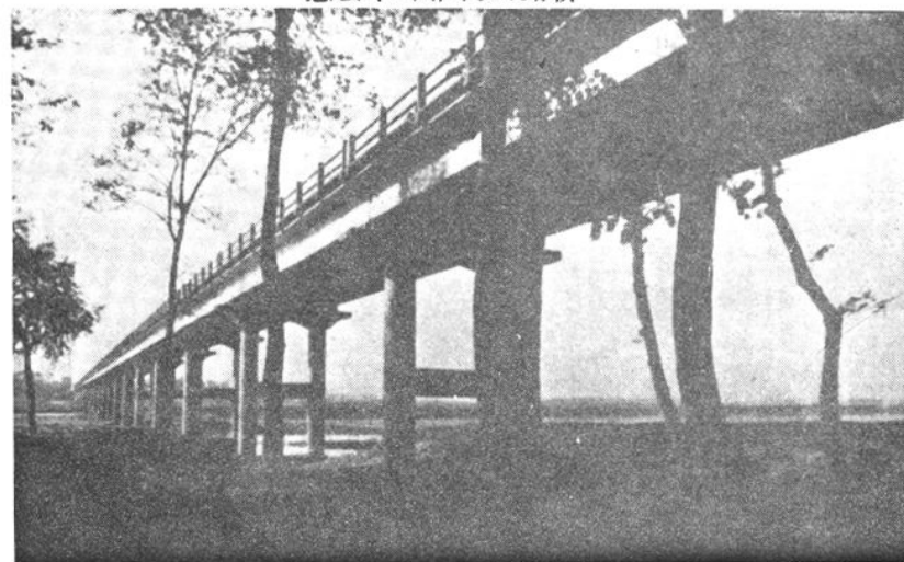
息县陡河沿（范楼）淮河公路桥
