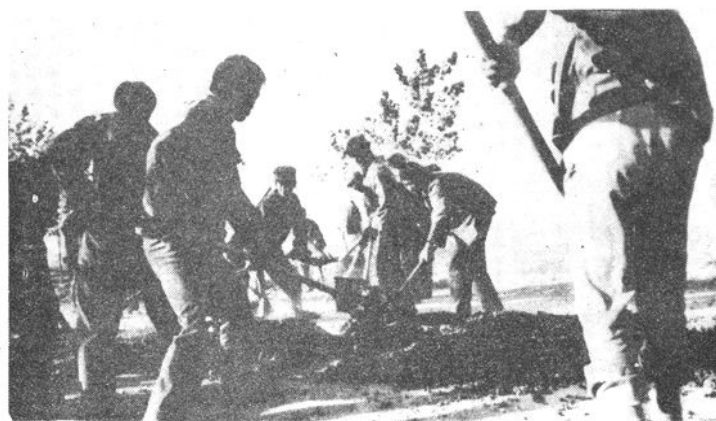
养护工人正在罗淮路中段紧张施工近影
