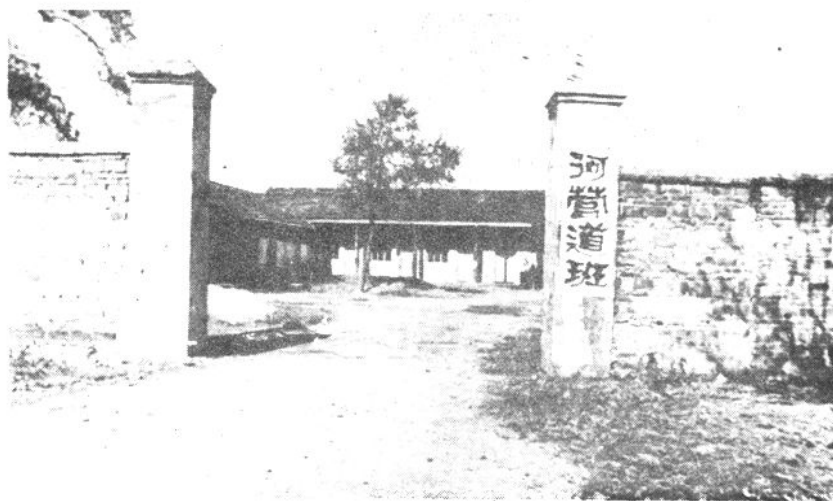
何营公路养护道班（位于县城西）
