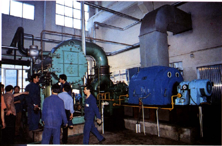
发电厂汽轮机和发电机
