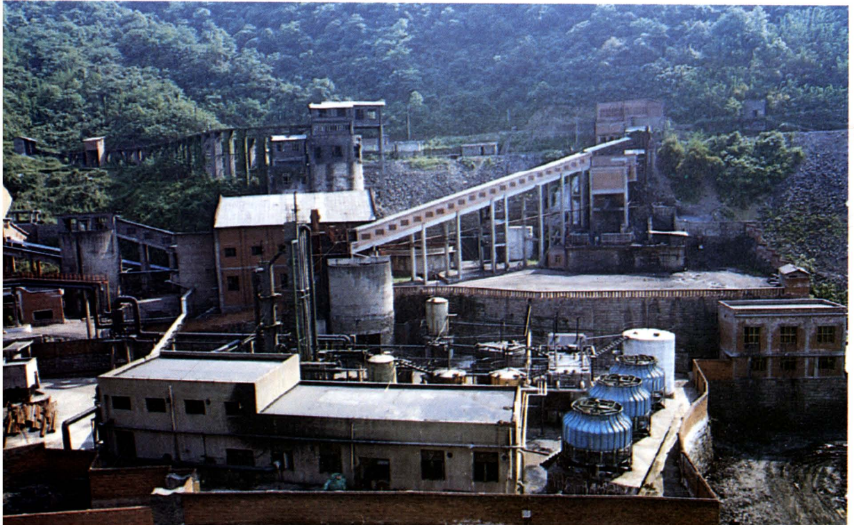
冷凝鼓风机工段回收煤焦油设施与选煤设施
