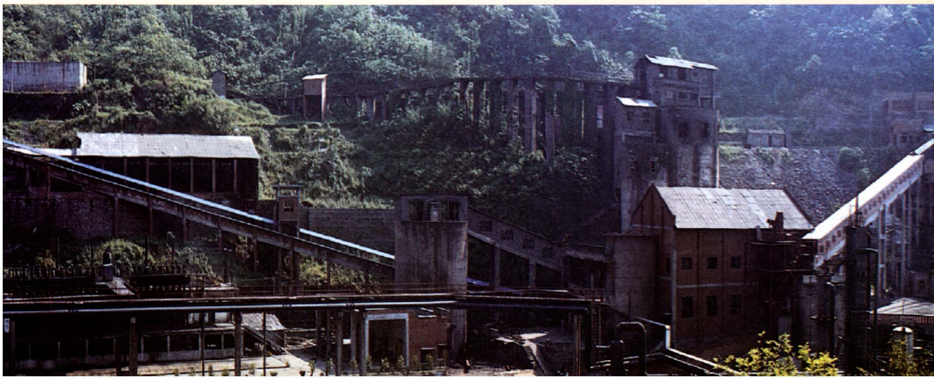
机焦通过305皮带输送机正往焦仓输送
