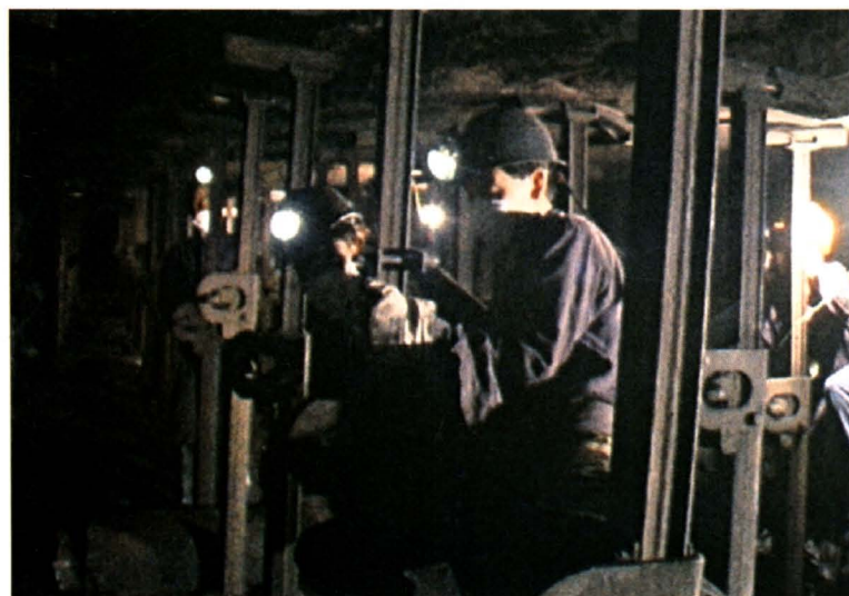
支护工在一井工作 面架设金属支柱
