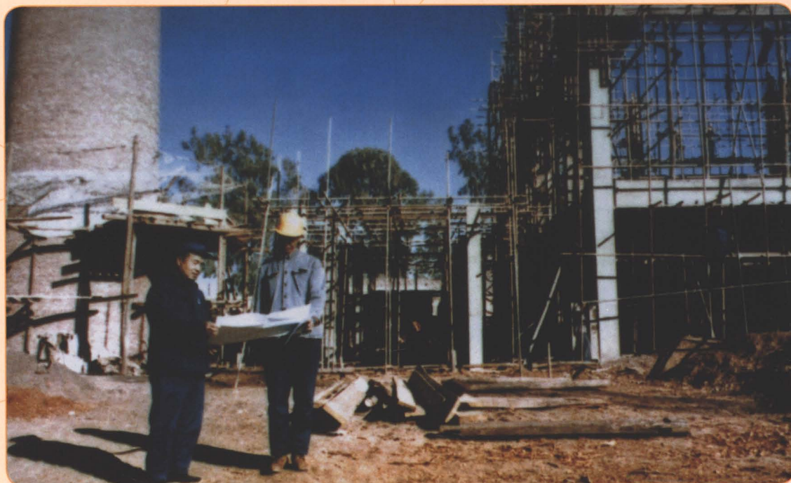
◎1985年，红河卷烟厂施工现场
