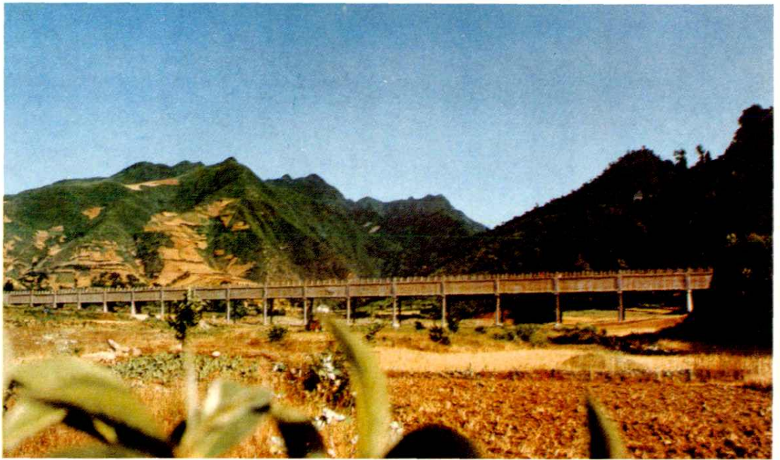
黑河引水渠道渡槽雄伟壮观
