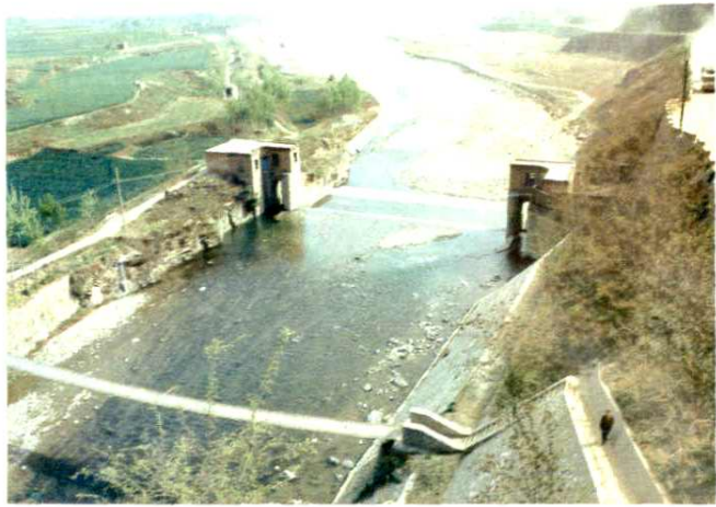
户县涝惠渠渠首
