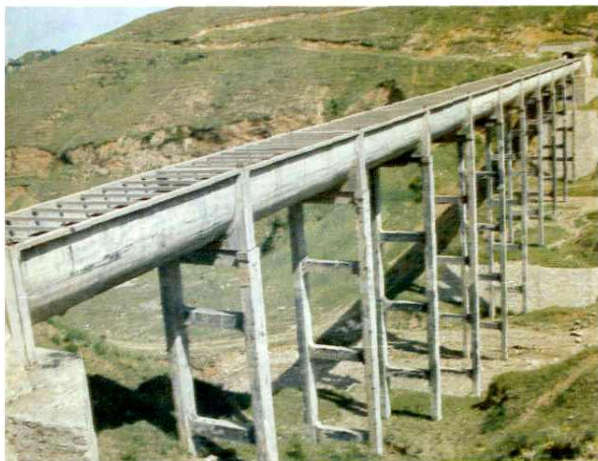
蓝田引岱工程白岩沟渡槽
