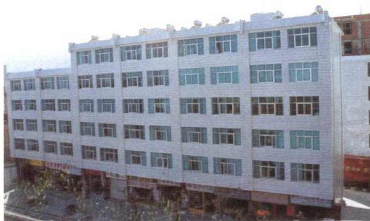
1997年7月动工建盖，1998年9月竣工使用的干警住宅、办公楼
