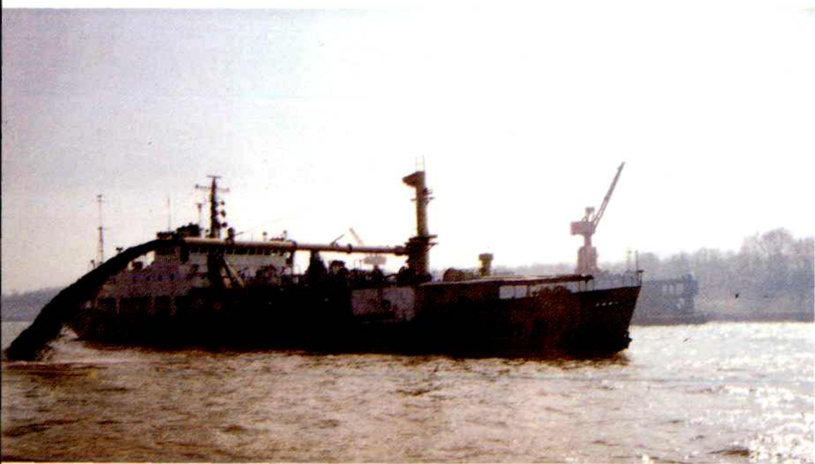
耙吸式挖泥船在武汉施工
