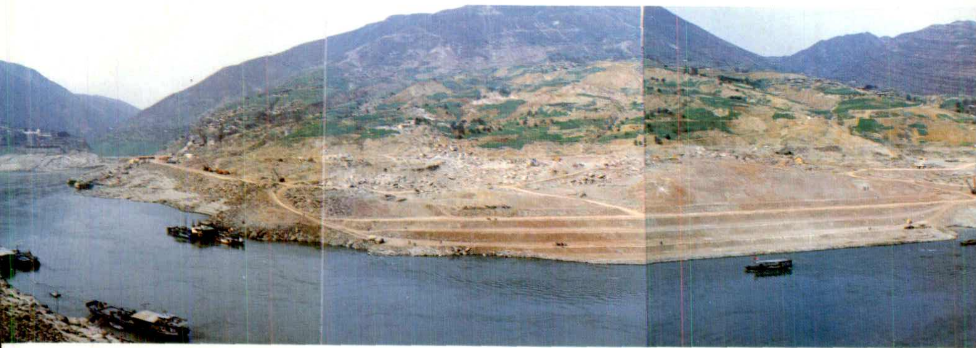
鸡扒子滑坡工地全景
