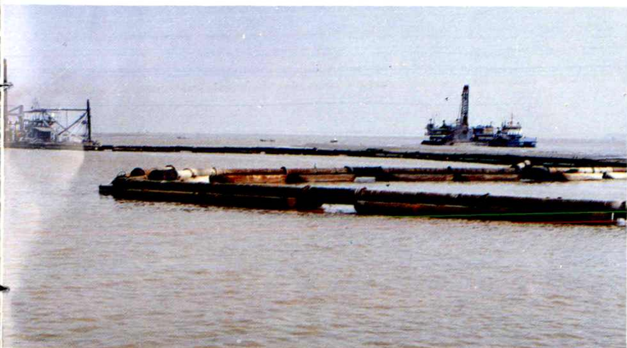
绞吸式挖泥船在武汉港江岸作业区施工
