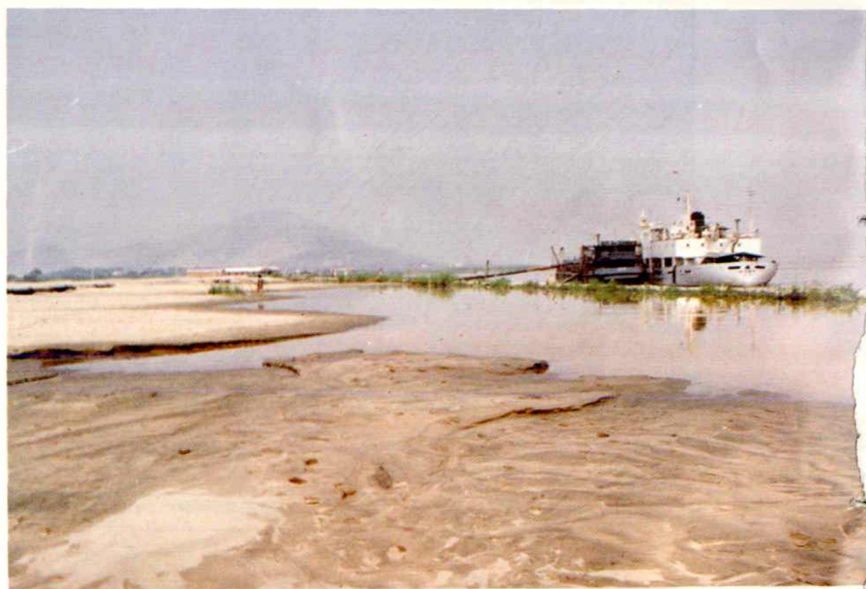
耙吸式挖泥船在南京施工
