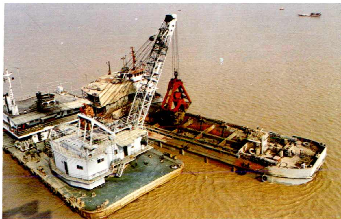
抓斗式挖泥船在裕溪口施工
