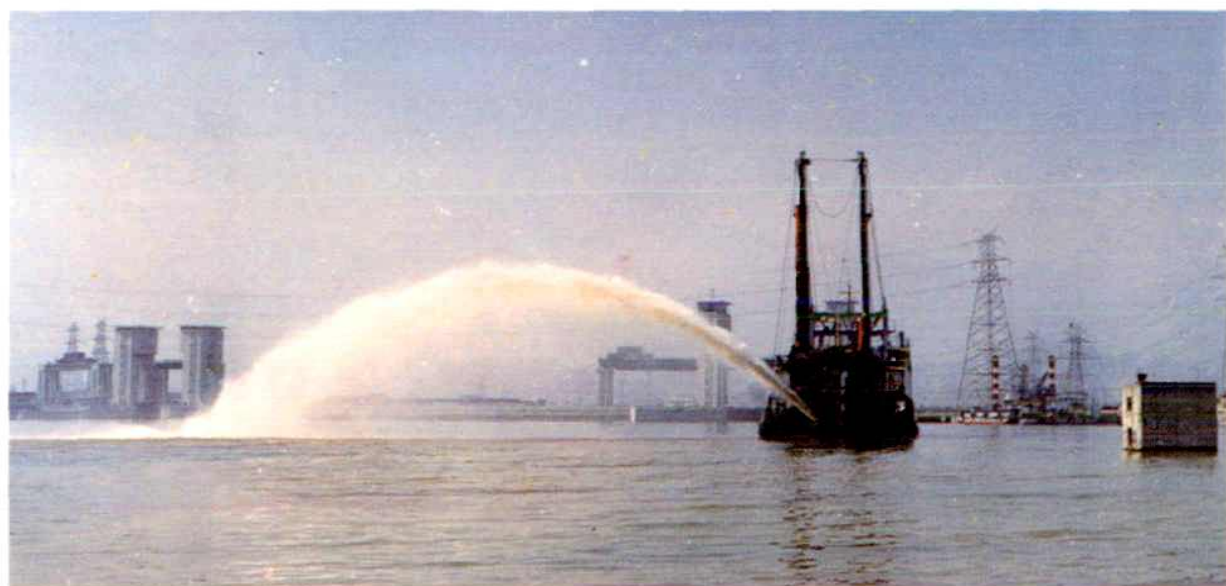
绞吸式挖泥船在葛洲坝三江上引航道施工
