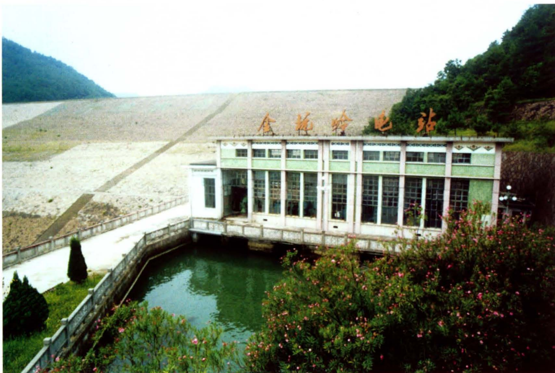
金坑岭一级水电站
