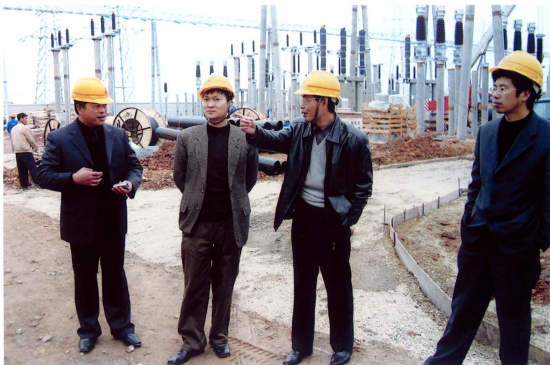
2004年12月常务副县长戴建平（左二）在局长万建平（右二）陪同下检查220千伏丰安变电所建设情况
