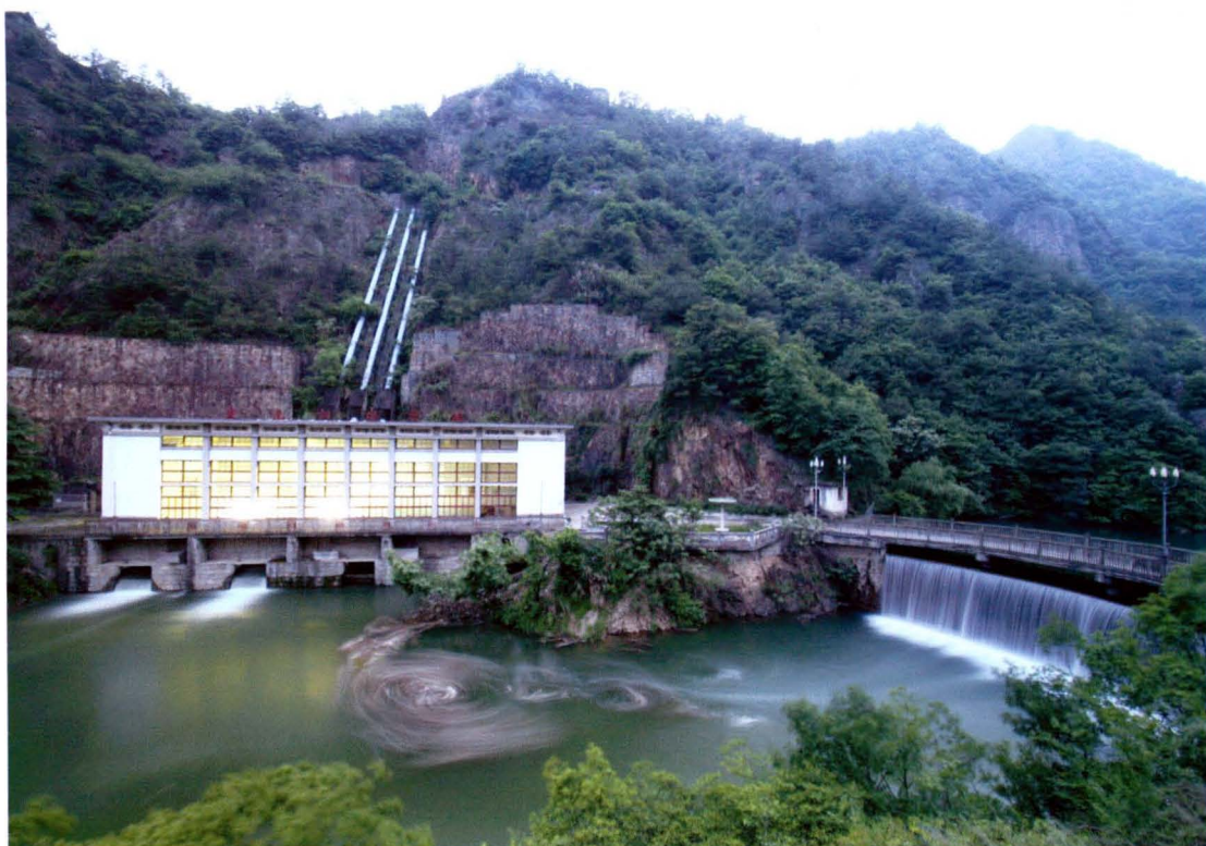
壶源江水电站外貌
