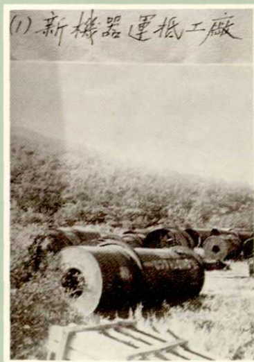
▲机件转运到栖霞工厂工地
