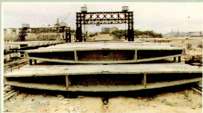
▲汕头海湾大桥箱形主梁
