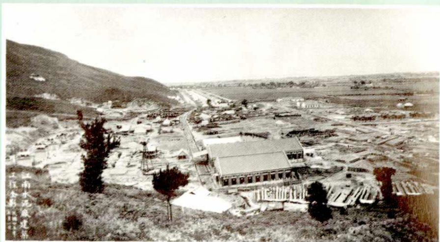
►大窑土建基础 竣工(1936年 7月)
