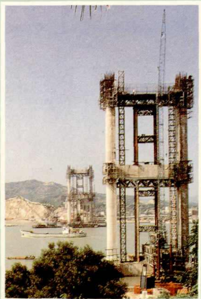
◀ 汕头海湾大桥主塔墩
