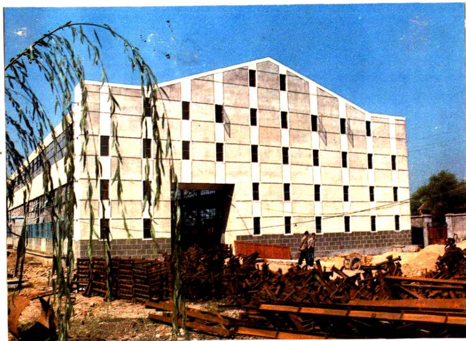
常州柴油机厂东青分厂金工车间
