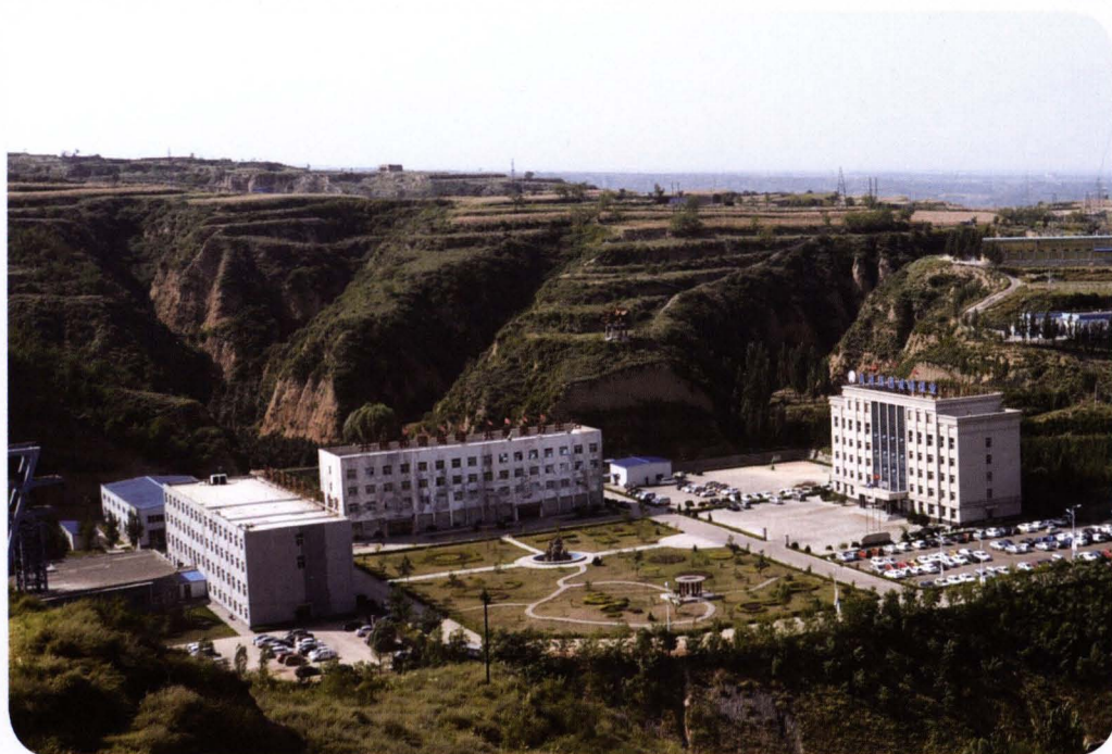
城峰煤业公司矿区
