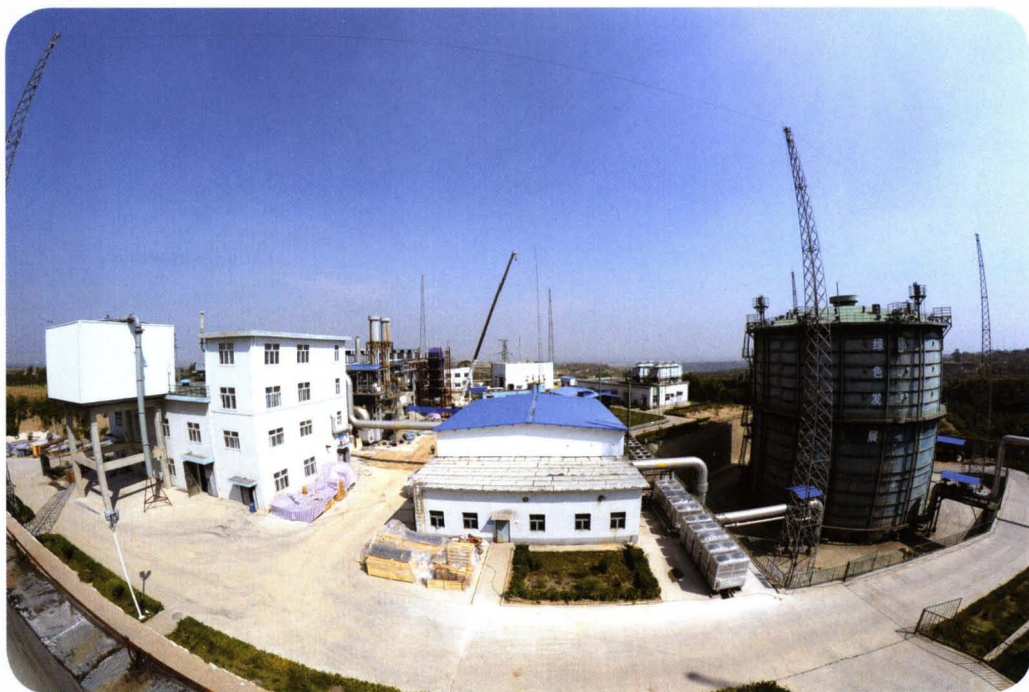
煤层气发电公司厂区
