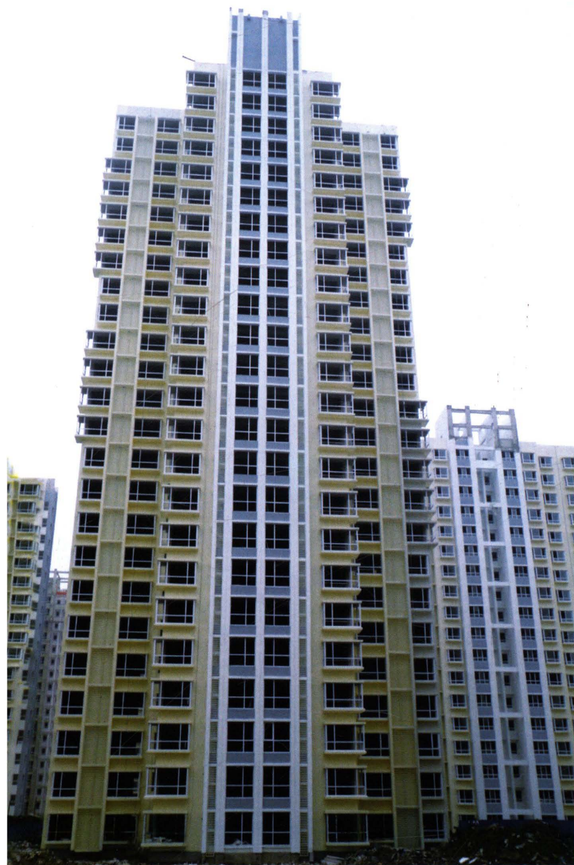
天津平祥大厦小区一角
