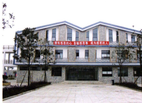
北川永昌二小办公楼(国家优质工程奖)
