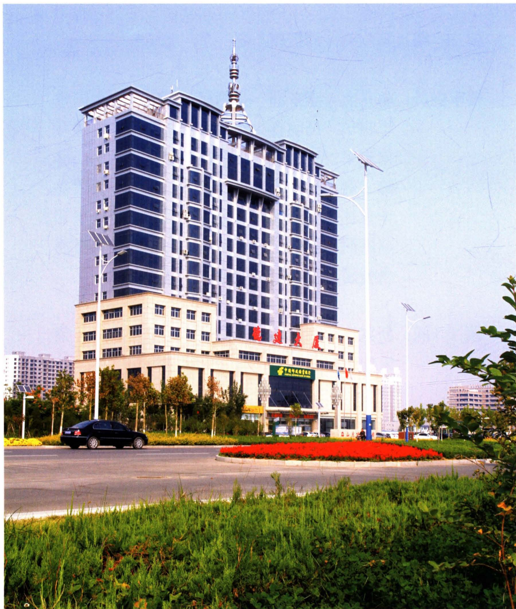
2006年迁入的集团自主开发——德建大厦（开发区三八东路）
