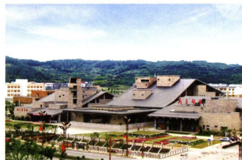
北川羌族自治县文化中心 (天府杯奖和国优工程)
