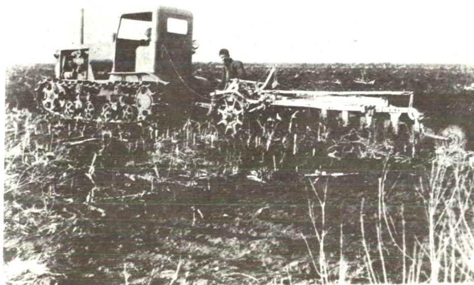
一九四九年春鹤山农场机务人员在进行开荒作业
