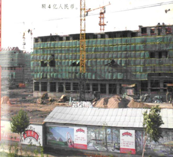
建设中的锦天华苑工程
