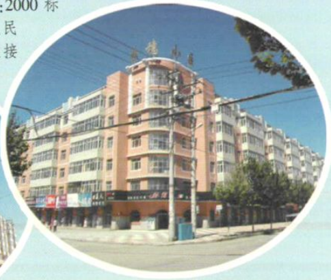
承建的永大盛世花园和金惠小区工程
