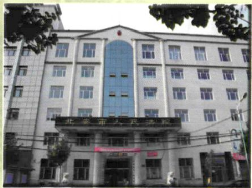
北安市人民法院办公楼
