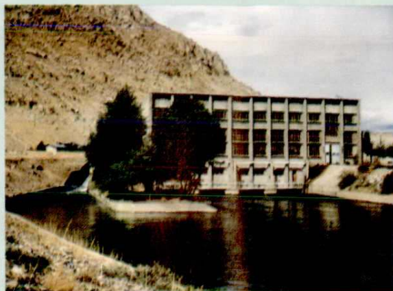
献多电站装机容量 2600 千瓦,1979 年 10 月 4 台机组并网发电。
