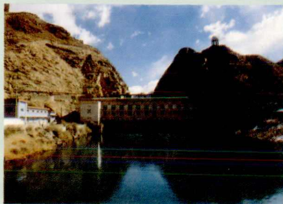
纳金电站装机容量 6 \times 1250 千瓦,1965 年全部建成投运。
