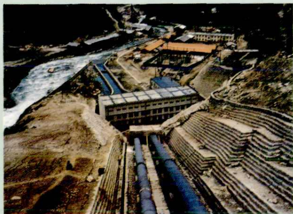
林芝八一电厂二级站,装机容量 3750 千瓦, 1989 年 5 月第一台机组投产。
