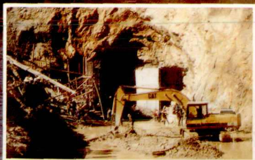
羊湖水电站直径 3.5 米的引水隧洞施工现场。 1989 年羊湖水电站 110 千伏高压线施工现场。
