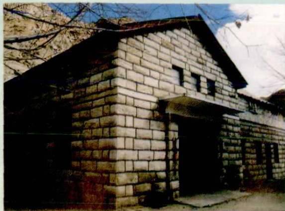
1956 年新建的拉萨电厂(夺底电站),装机容量 660 千瓦。
