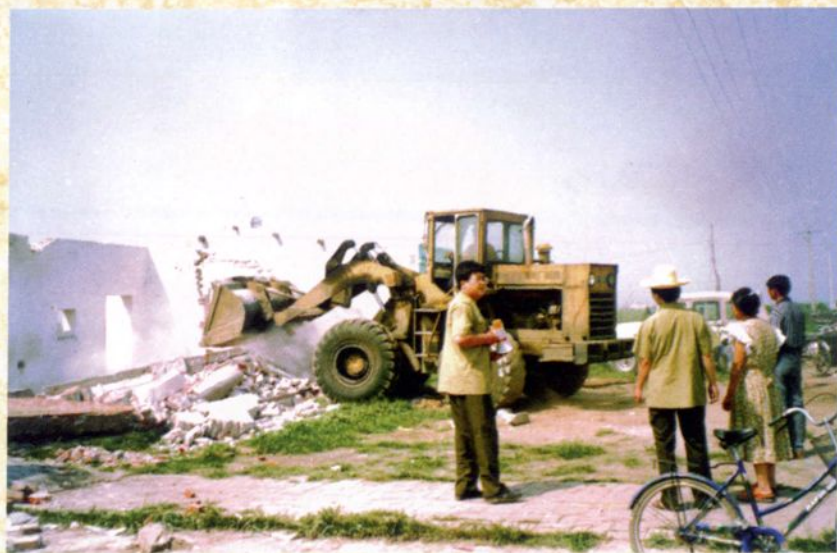
拆除违法建筑
