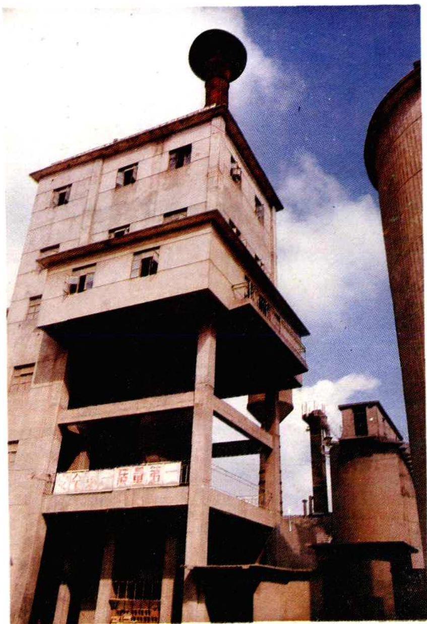
机立窑主体厂房
