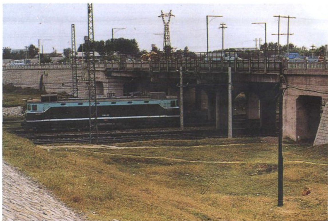
丰润城南立交桥
