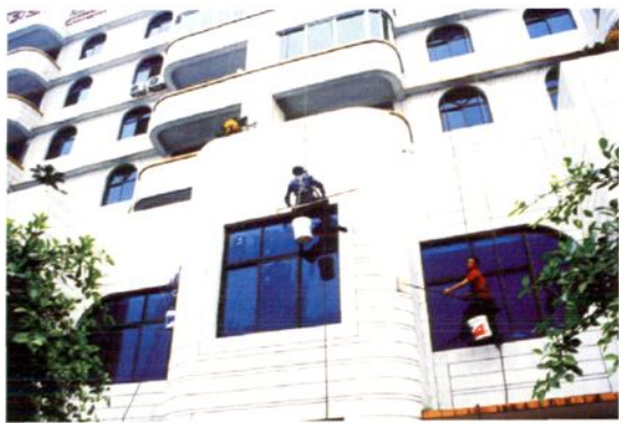
清洗临街建筑
