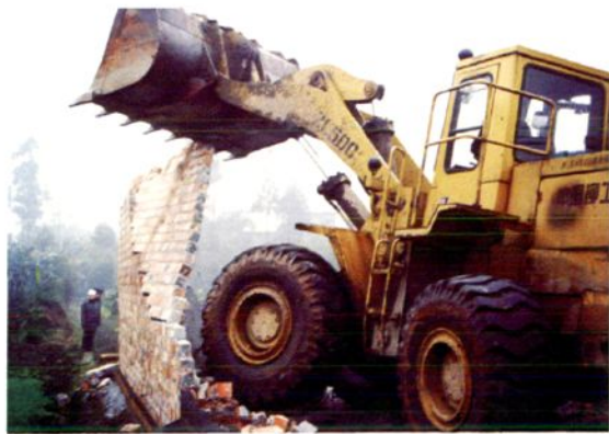
拆除违法建筑
