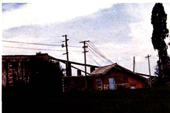
海口第一座抽水站—白鱼口唐家井抽水机站
