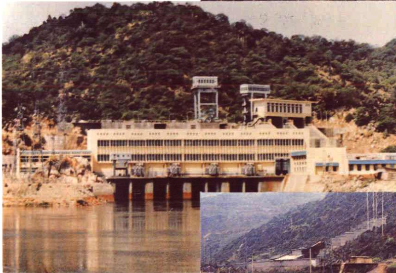
▲ 喀麦隆拉格都水电站厂房外景
