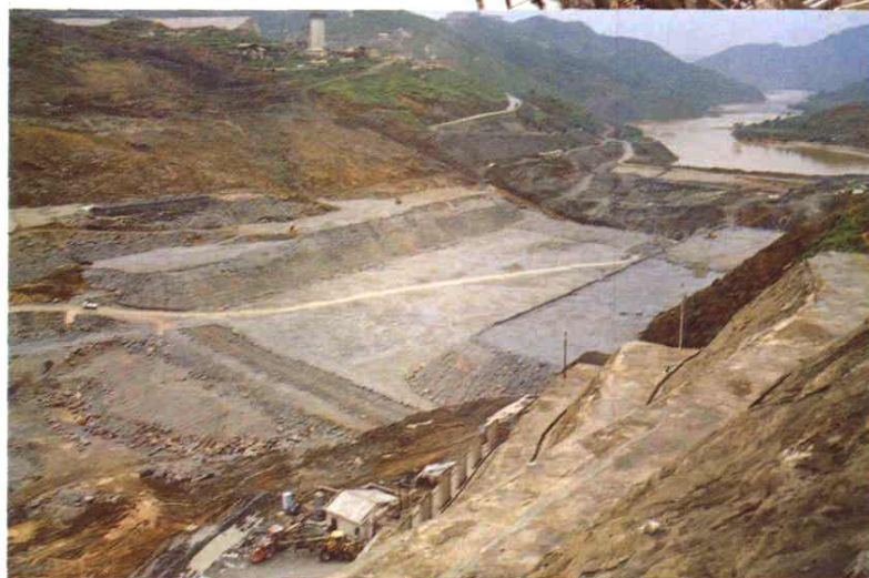
◀ 天生桥一级水电站 坝基开挖现场
