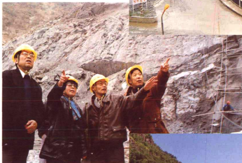
◀院领导在天生桥一级水电站工地
