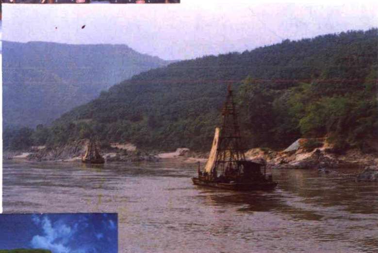
► 景洪水电站坝址河中钻探
