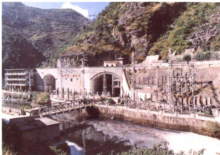
►西洱河一级水电站
