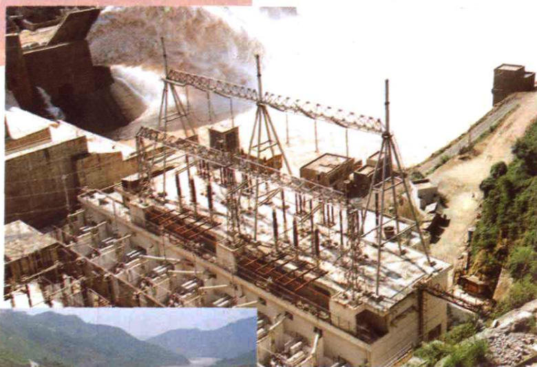
▼ 漫湾水电站 500kV 开关站
