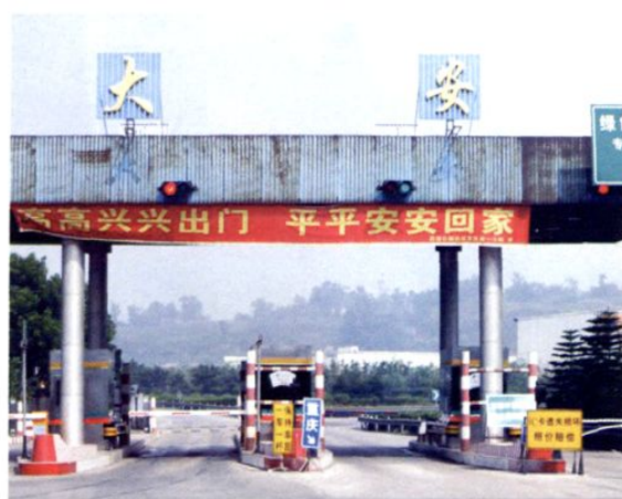
成渝高速公路大安道口
