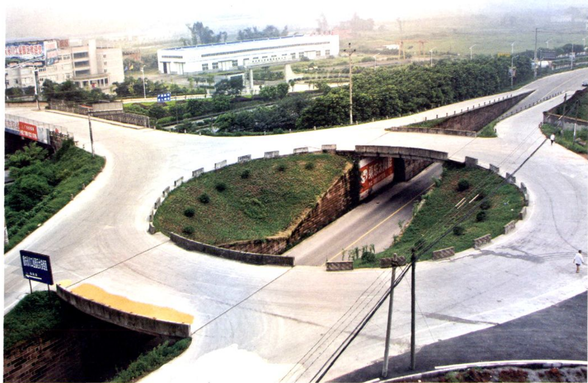
成渝高速公路大安道口立交桥
