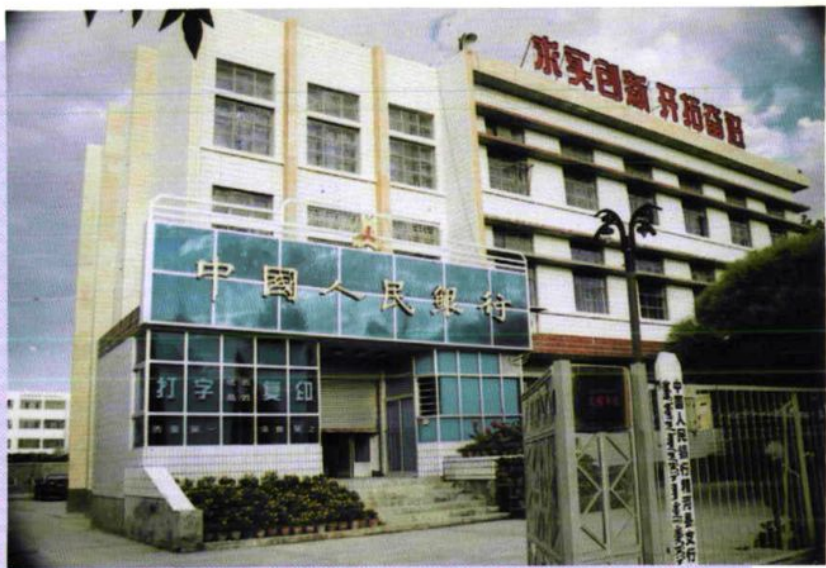
中国人民银行精河县支行办公营业楼
