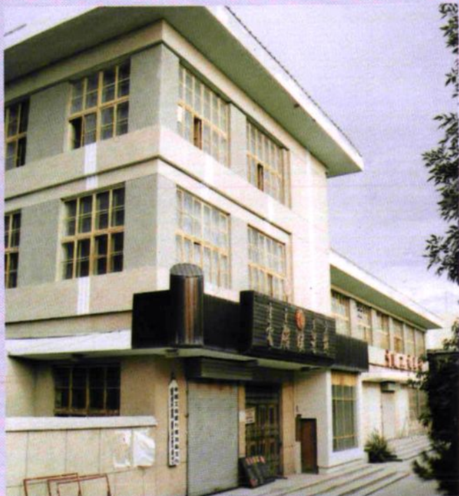
中国工商银行精河县支行办公营业楼
