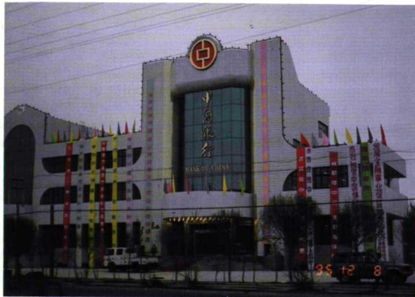
中国银行精河县支行办公营业楼
