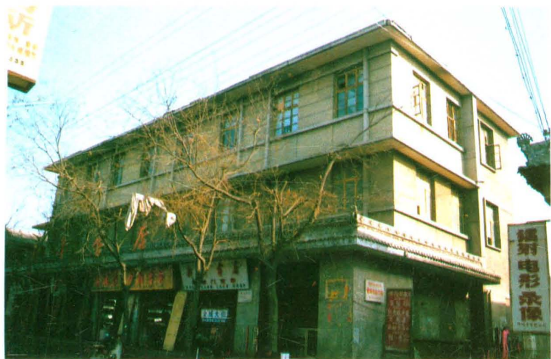
金城门市部大楼
