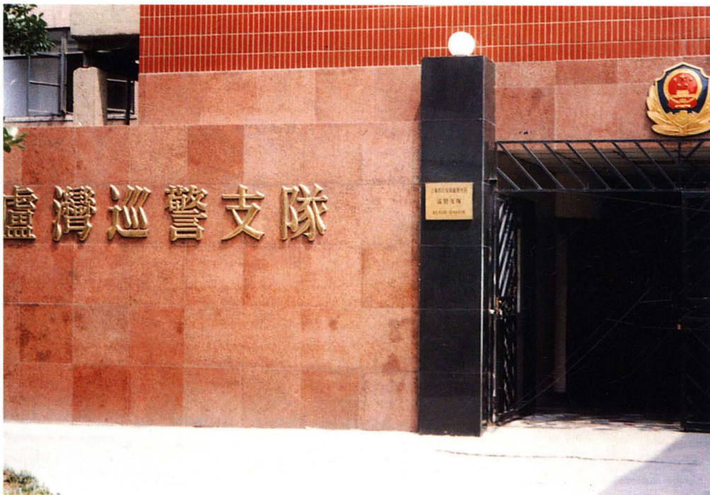
卢湾巡警支队办公楼
