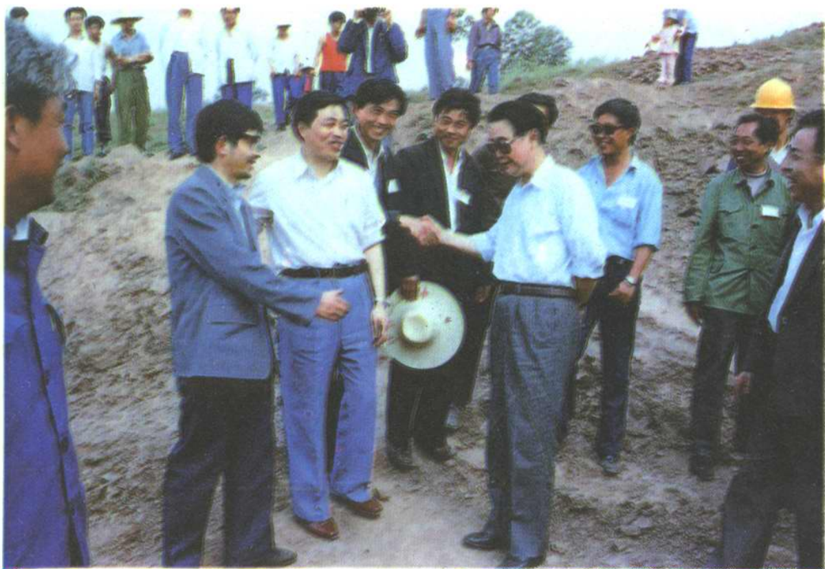
1987年4月23日，国务院副总理李鹏视察重庆江北机场工地。
