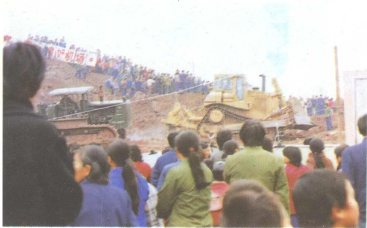
江北机场破土动工。
