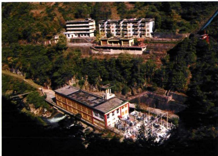
◀ 主力电站。装机3台，总容量7500千瓦
