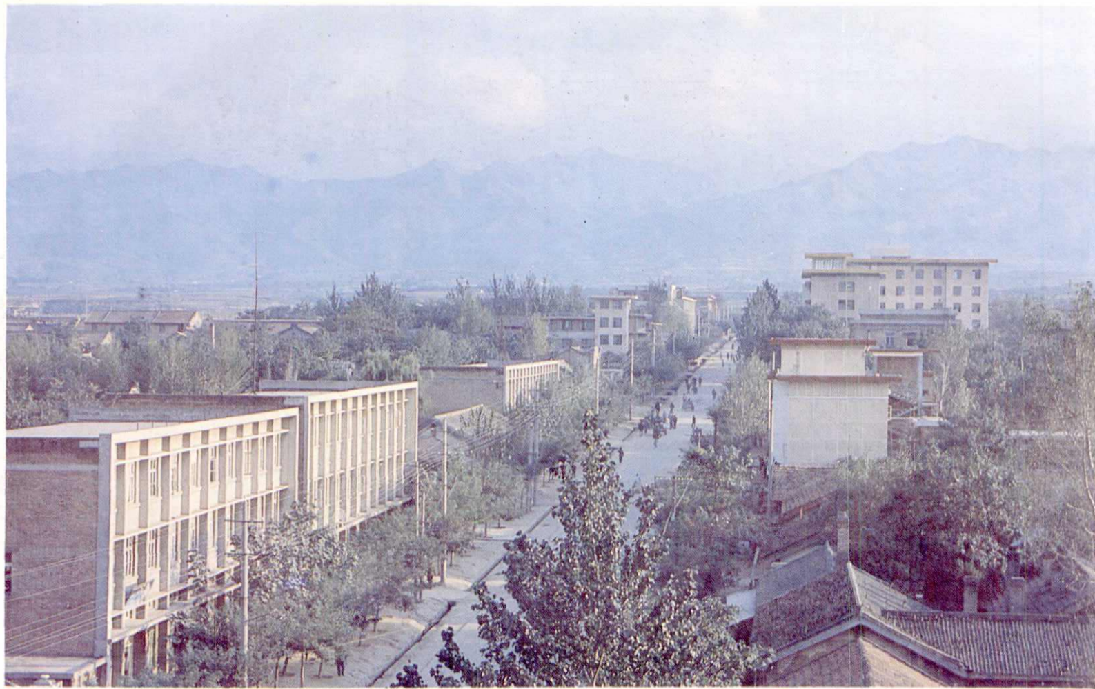
建设中的新潼关
