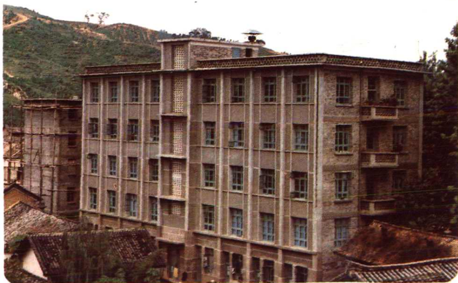
云县人民政府办公大楼
