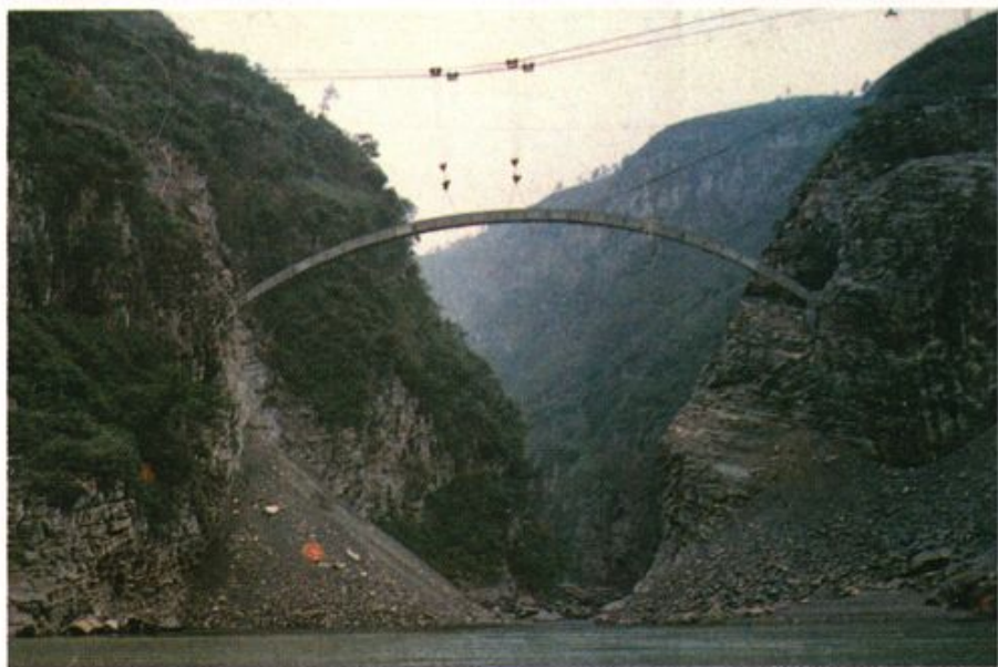
► 双白路大溪河口 大桥正在建设中
