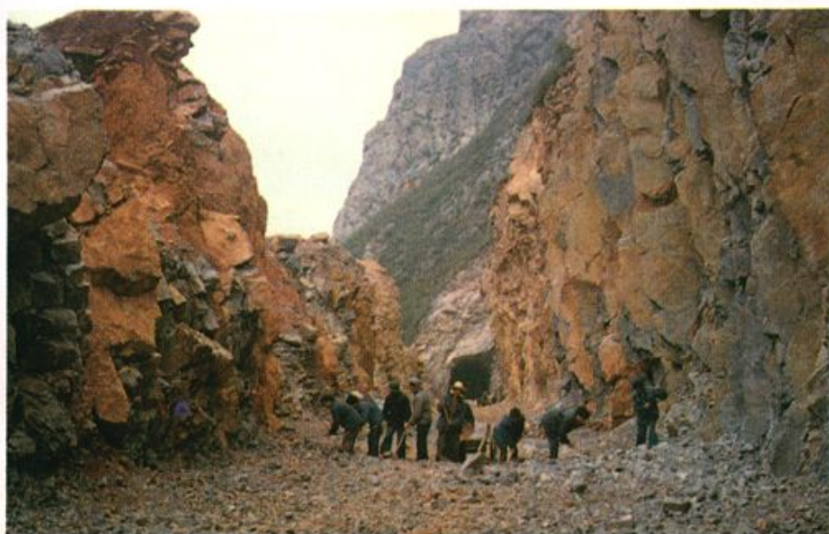
◀ 劈山要路—— 双白路路基施工
