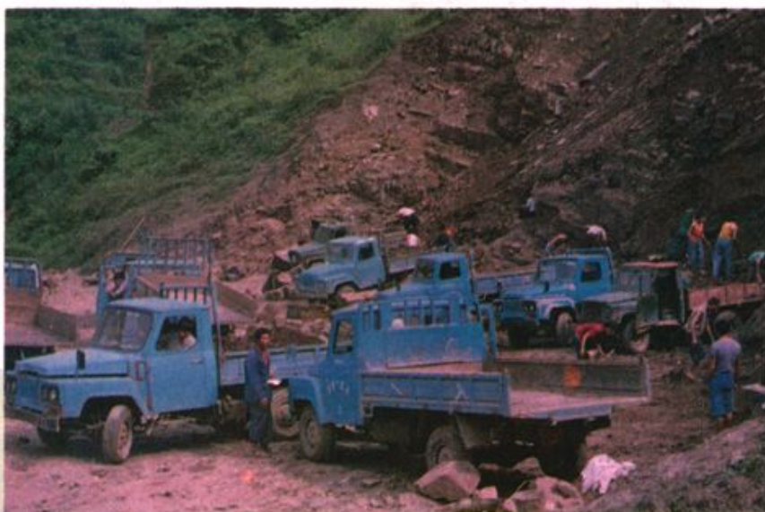
▲武隆—彭水公路巷江段改建工程施工现场
