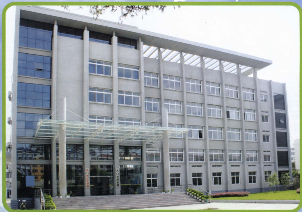
▲ 市卫生局办公大楼
