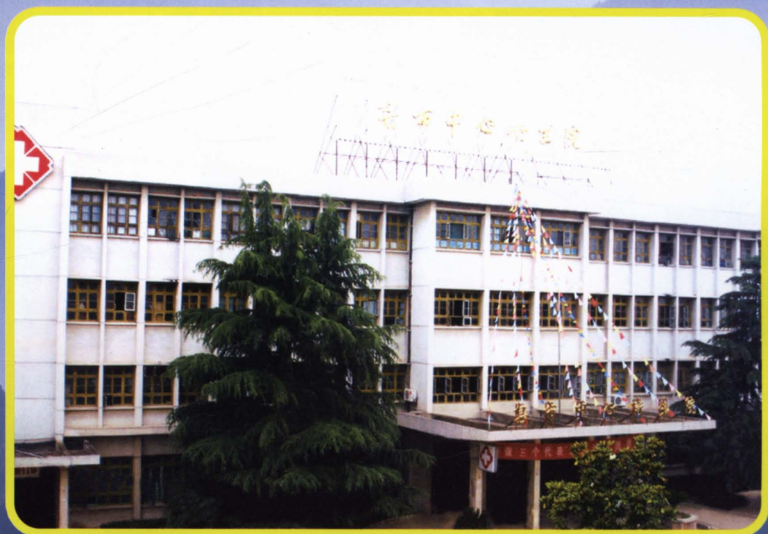
▲ 皂市中心卫生院门诊部
