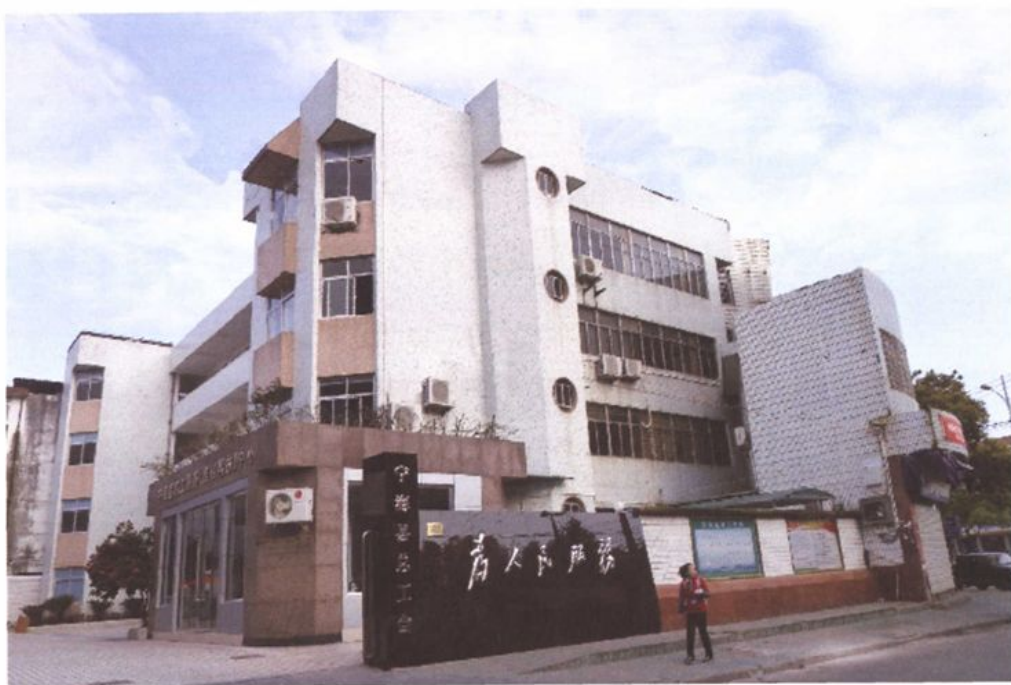
宁海县总工会办公楼
