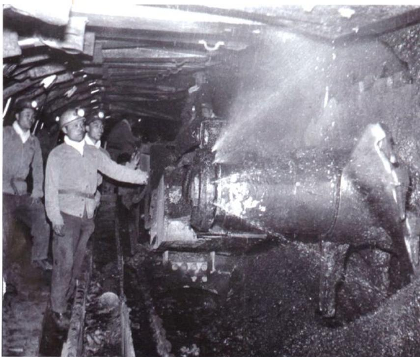
1978年2月5日，八一采煤队由炮采改为综采，当年生产原煤48万吨。（图为国产第一套综采设备）
