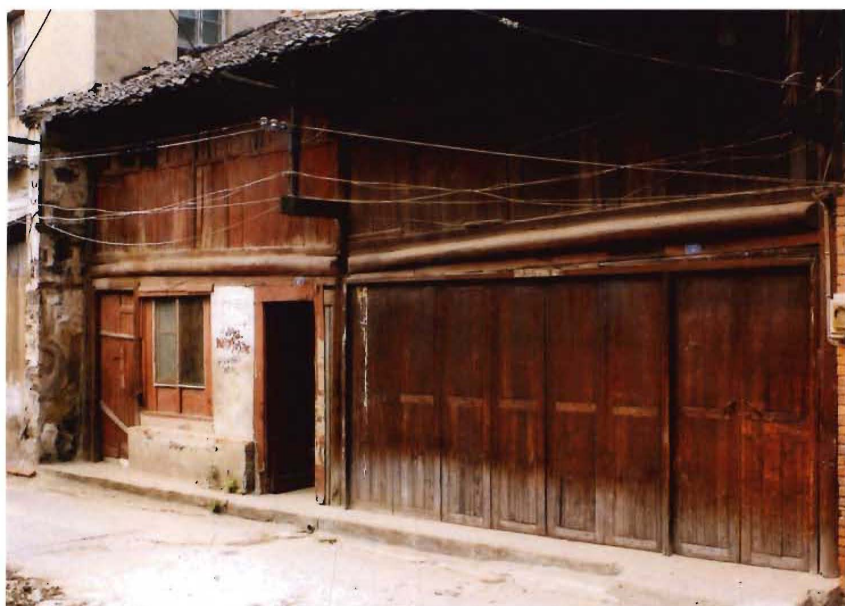
“金西门”外正街商铺旧址
