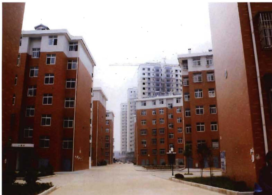
社区居民旧居拆迁还建房
