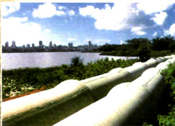
对澳门供水工程输水管
