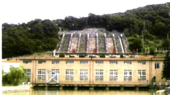
广东珠海洪湾泵站
