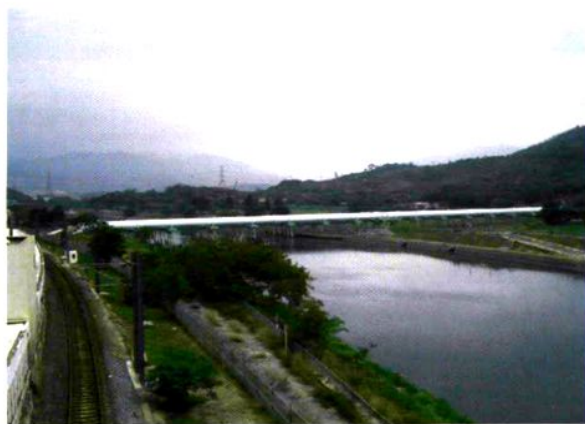
横跨深圳河的广东东深供水工程输水管
