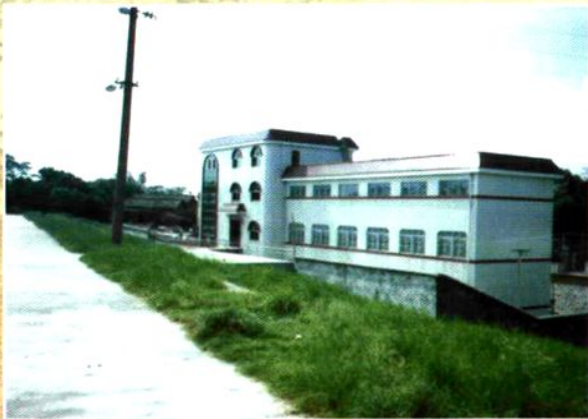
广西桂平城区大坑口防洪排涝工程
