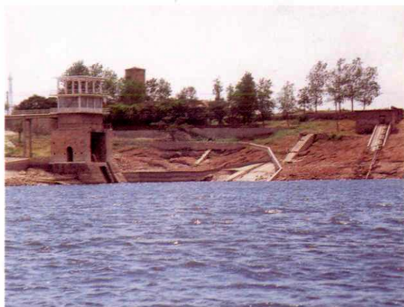
放水洞进水闸
