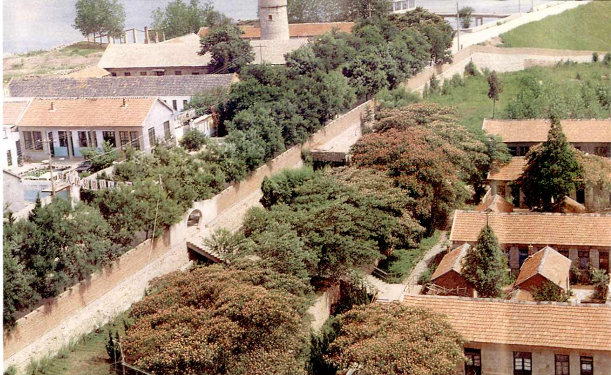
水库管理处一角
