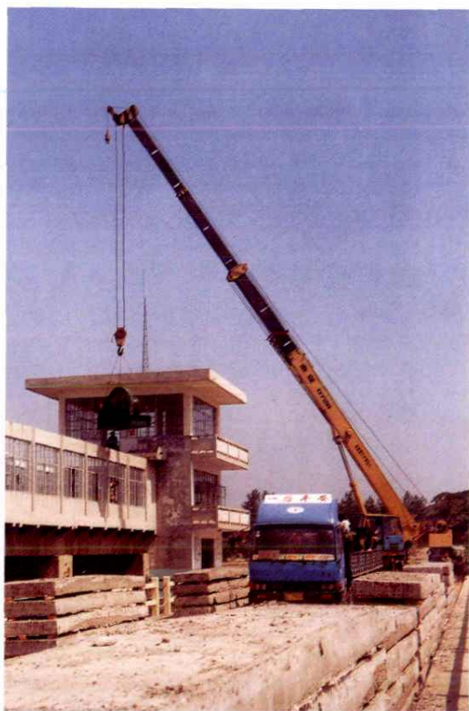
溢洪闸改建工程启闭机吊装
