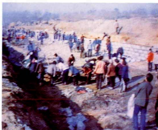
丰收渠衬砌现场
