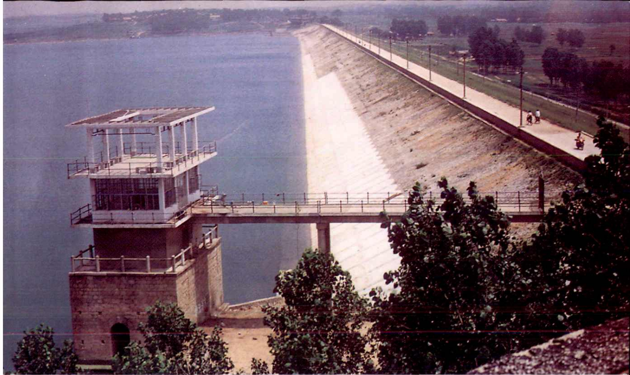
水库大坝全景
