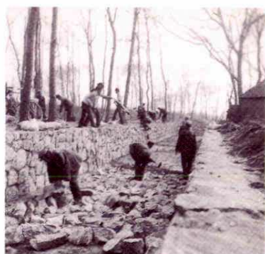
一干渠石砌现场
