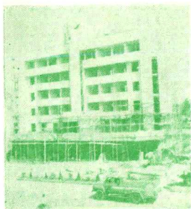
△贡江建筑二队承建的 县检察院办公大楼
