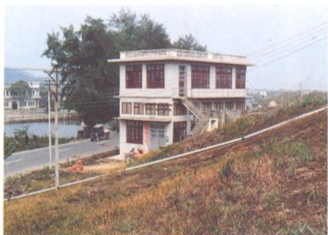
沙头区山根电动排水站
