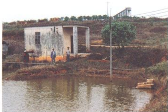
大沥区乌泥忽山塘电动灌溉站
