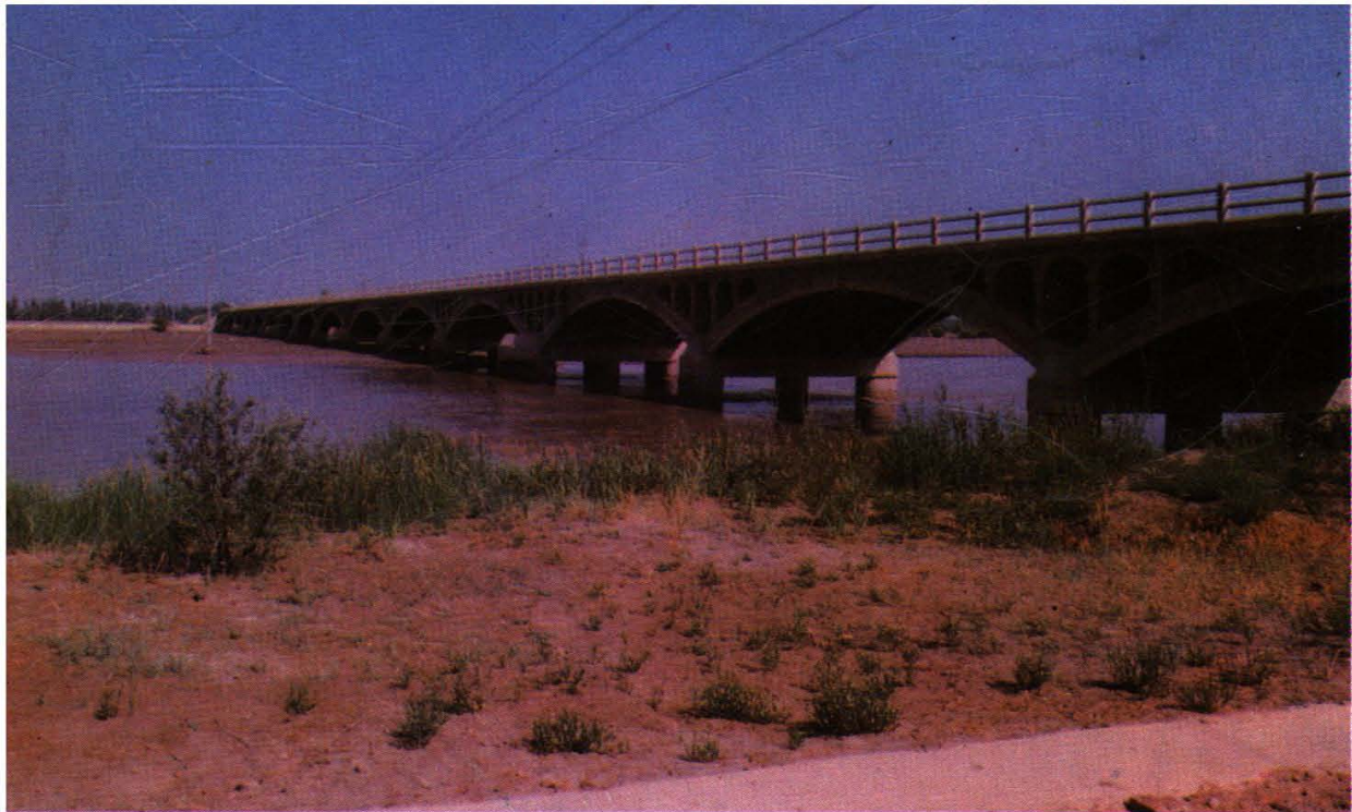
金塔县县乡公路鼎新黑河大桥
