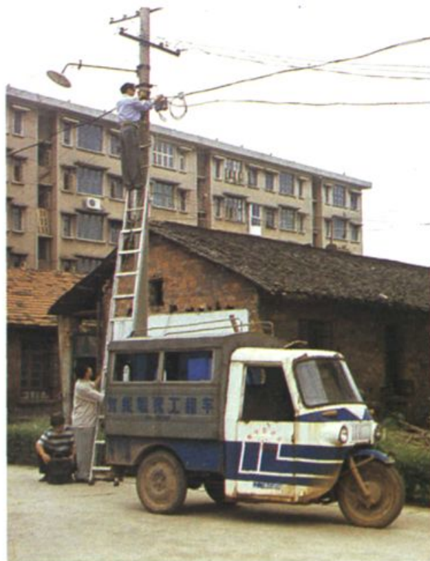
县有线电视台工程人员在维修线路
