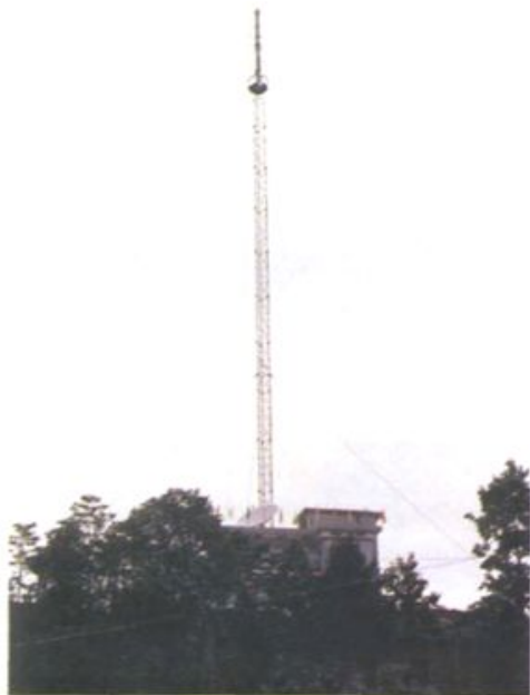
1992年5月22日建成开播的青山桥电视转播台综合楼及电视发射铁塔
