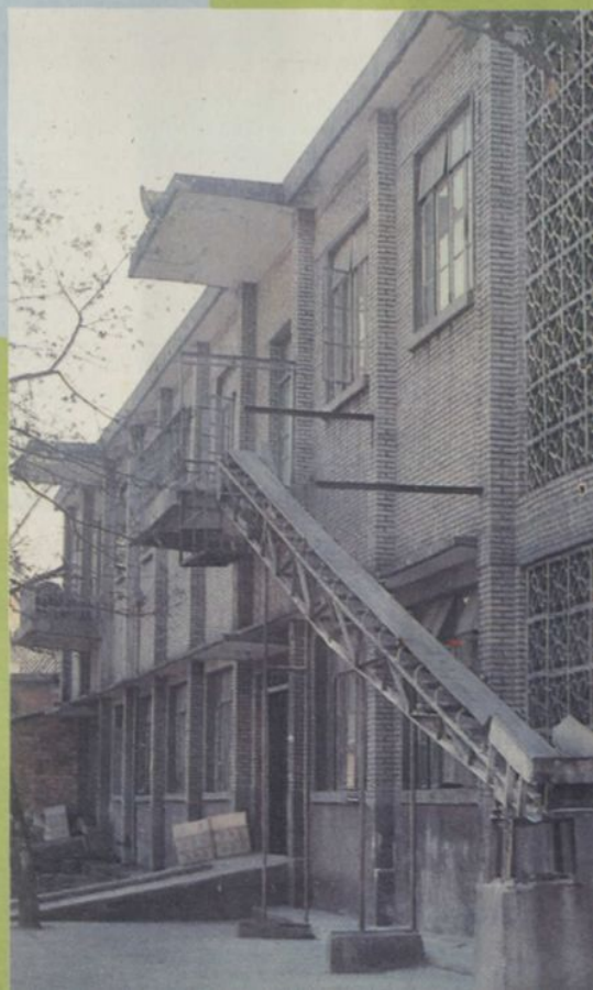
粮油食品厂面条车间厂房
