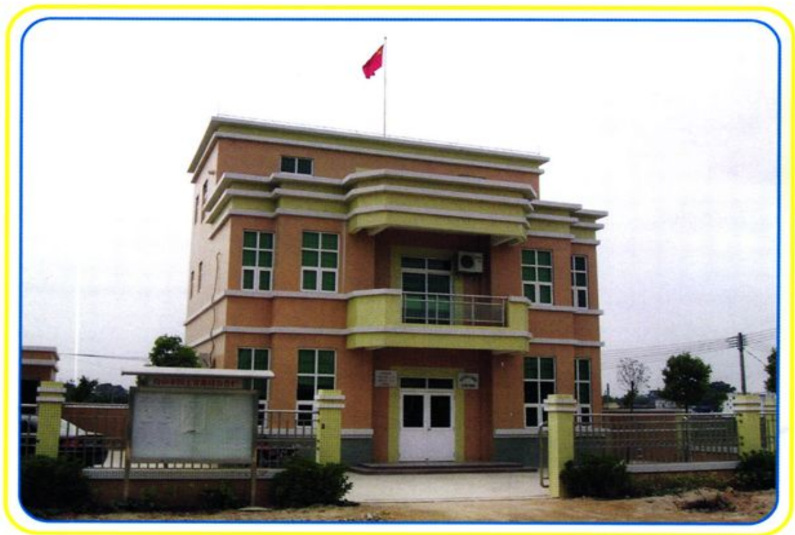
▲ 国土资源管理大楼
